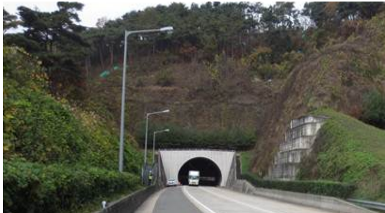
(시점부 절토사면 전경)
